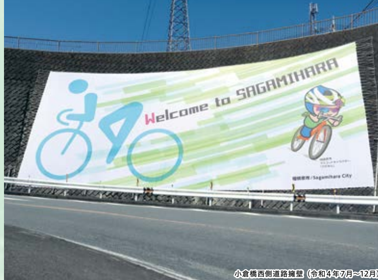
小倉橋西側道路擁壁（令和4年7月～12月）
